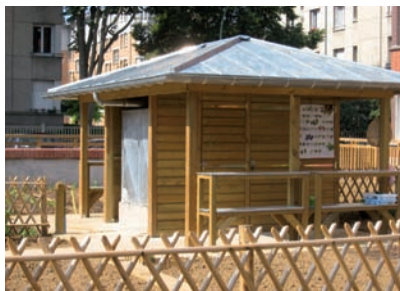
Abri toiture en zinc avec récupération des eaux fluviales
